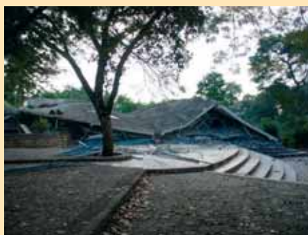
Les bâtiments du primaire détruits par le séisme
